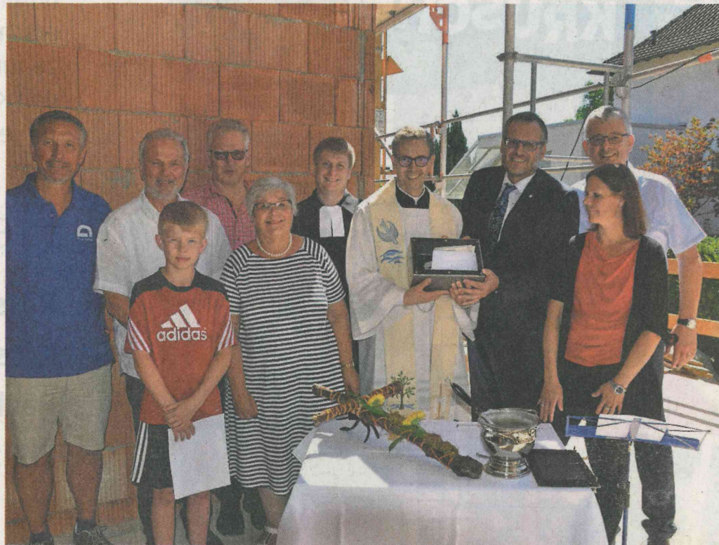
Eine Kiste wurde als Grundstein in das Fundament im Eingangsbereich eingebaut. Foto: Jochen Werner
